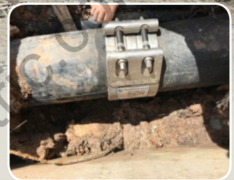
▲ PE Pipe Repair
