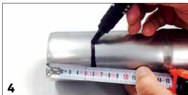
4 Marcatura quota d'innesto / Marking the insertion's depth
